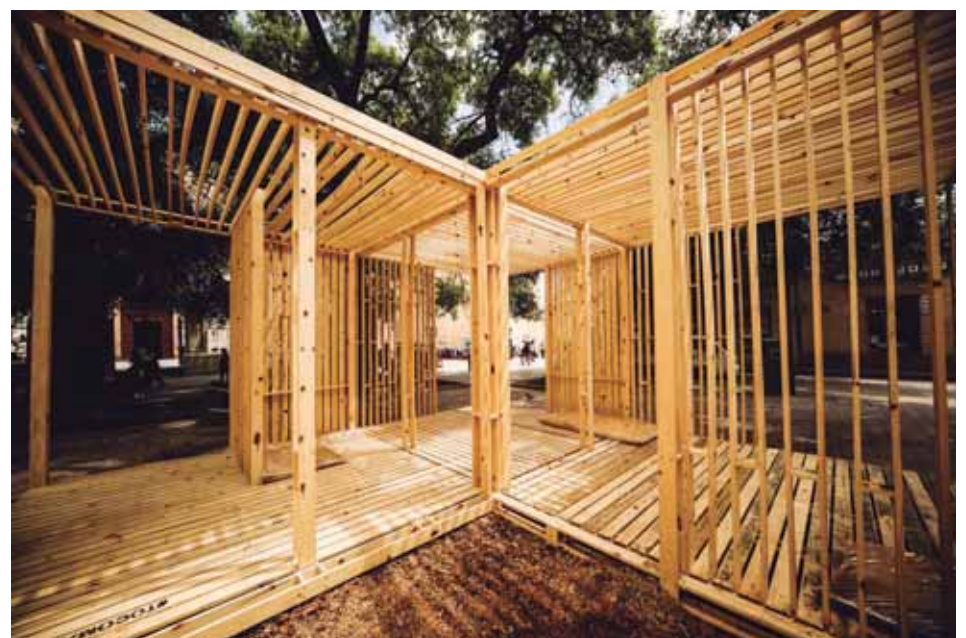
#M.U.H.! Es de un prototipo de vivienda de madera, que apela a la maximización del recurso renovable de la madera cultivada en la región: principalmente pino Ellioti. Promueve el desarrollo de viviendas de madera de alta prestación y confort: modulares, flexibles y contemporáneas, asociadas a la utilización de la ciudad construida como soporte de estas nuevas construcciones, principalmente terrazas y techos de casas en áreas centrales o pericentrales de barrios consolidados.
